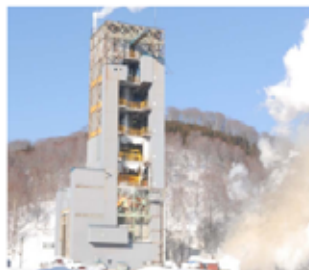
厚肉タンクステージ燃焼試験実施状況(全景)
